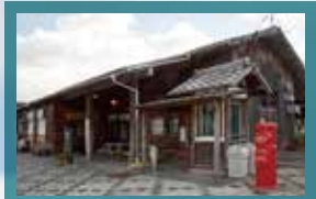
■天竜二俣駅本屋 木造平屋建、切妻造の駅舎。待合室は、中央部を高くした船底天井。
