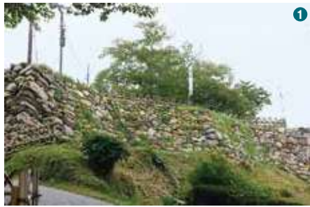
1 天守曲輪の西側の石垣は、地形に沿った「屏風折れ」で、死角をなくすことで防衛的にも攻撃戦術的にも優れた石垣づくりの手法となっている。
