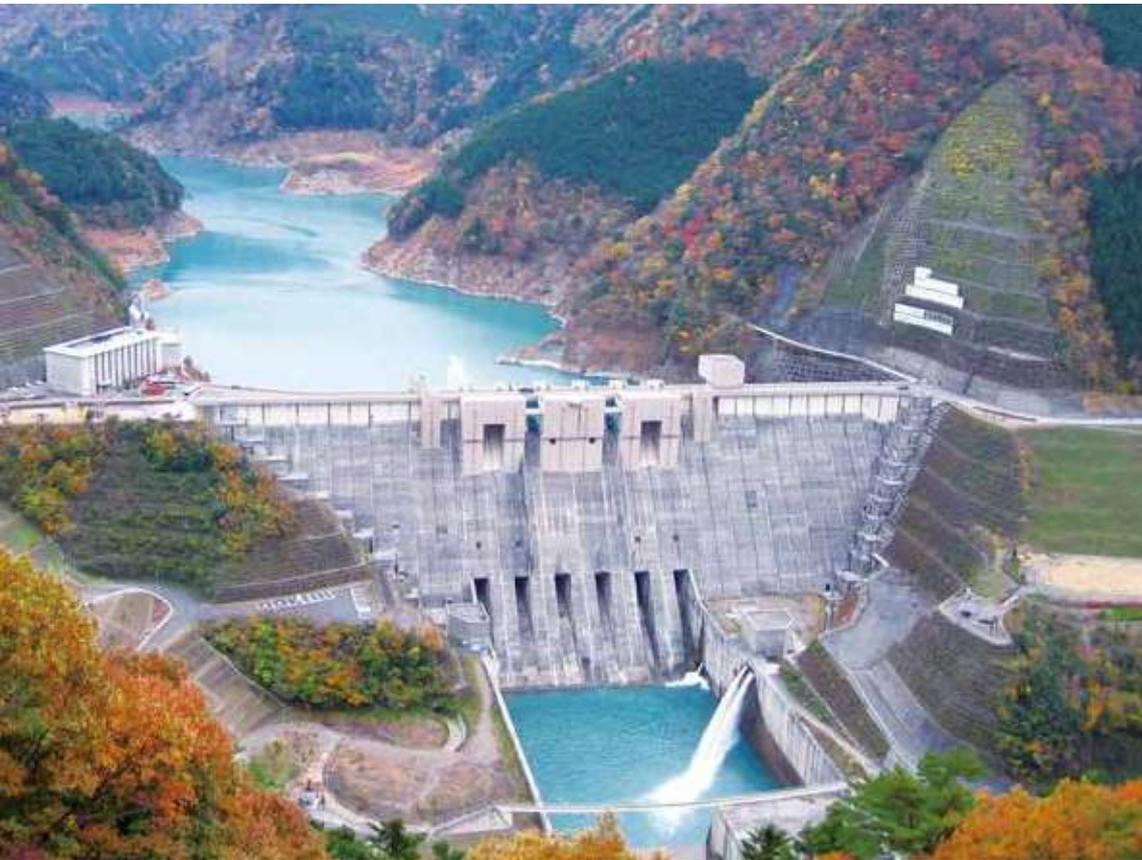
両岸をまっすぐつなぎ、ダムの堤体の重さで水を堰き止める重力式コンクリートダム。左右対称の美しいデザインで、天頂部分には「桜御影石」が使われ、優美な表情を醸し出している。上部に非常用洪水吐が2門、下部に国内最大級の常用洪水吐が6門設置されている。
